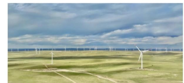
内蒙古锡林郭勒盟东尼特左旗，因常年受半干旱大陆性气候影响，风力强、风量大。通过对蒙能投东苏旗巴彦杭盖项目所在地风资源、地形及环境特征等方面进行深入分析，结合中国海装丰富的规划设计及工程实施经验，采用基于多源数据融合的LiGa风资源评估系统及多目标自寻优技术对项目进行设计优化，蒙能投东苏旗巴彦杭盖风电项目最终选用中国海装3.XMW平台机组。
