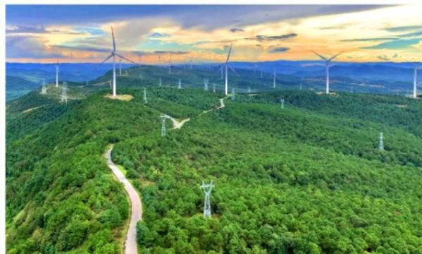
马龙对门梁子项目位于云南省马龙县城西南侧，海拔高度2100m~2300m之间，装备有45台海装造H102-2.0MW机组，总装机容量为90MW。项目首台机组于2015年4月2日发电，全部机组于2015年08月17日完成投产。2021年全年，在年平均风速6.56m/s的情况下，项目实现发电量2.16亿kWh，年平均利用小时数为2400h，平均可利用率99.78%，年可利用小时数、年上网电量均超过可研水平。
